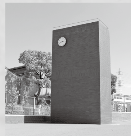
△高さ6.6mのレンガの時計塔がそびえ立っています
